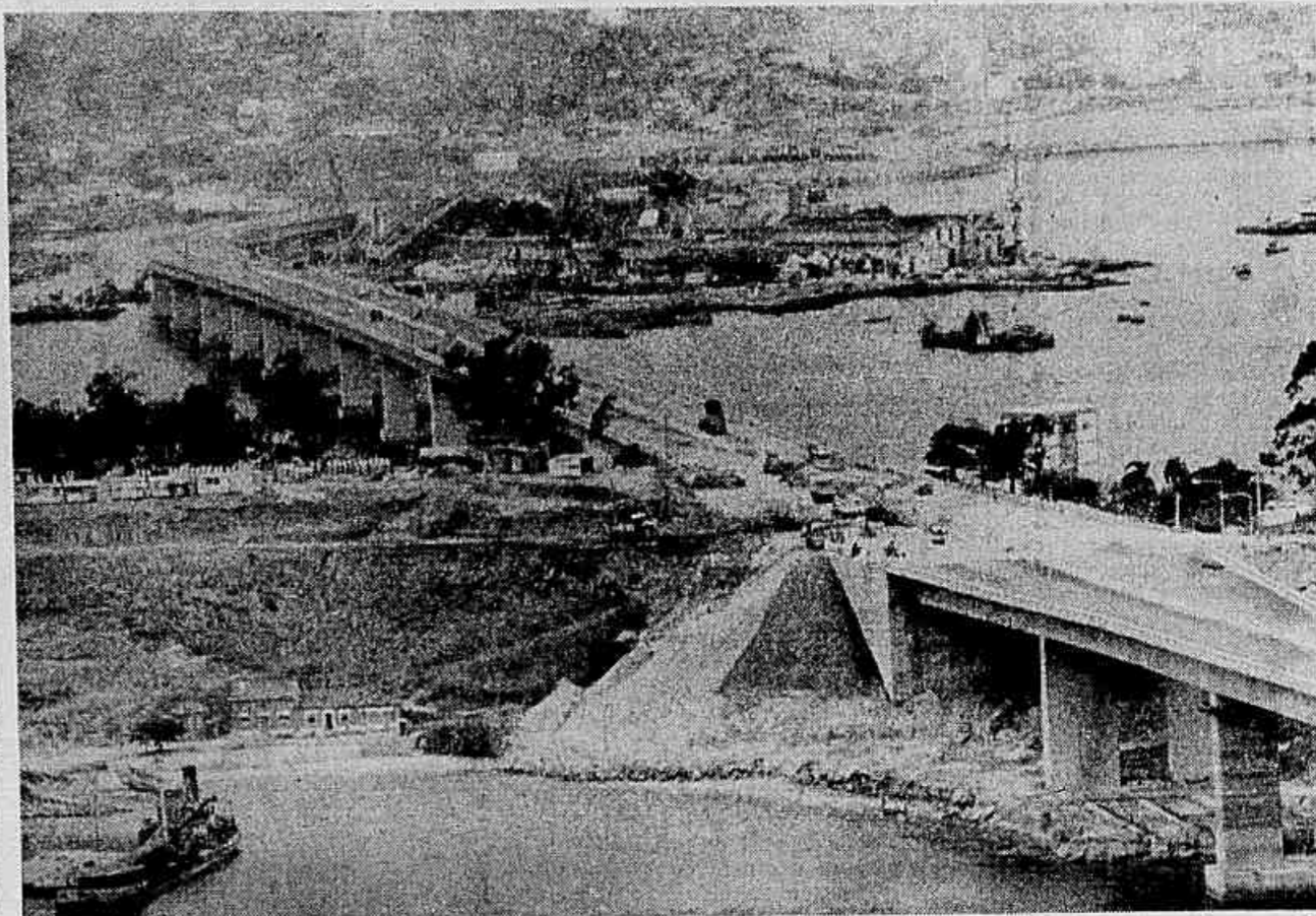
Nos terminais da Ponte estão agora sendo realizadas as obras de acabamento para inauguração
